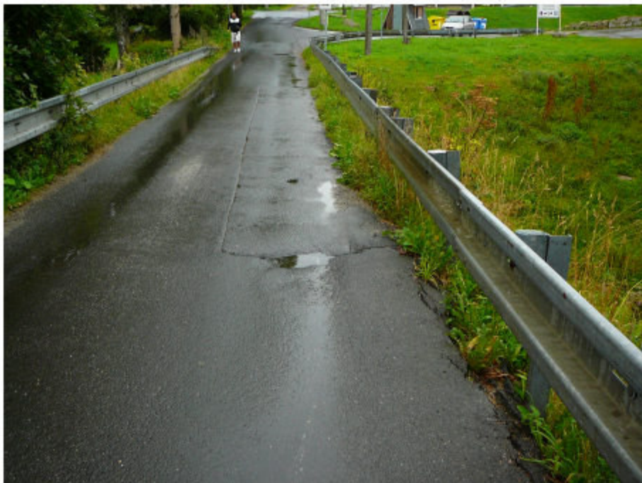
09_TRHLINY VE VOZOVCE NA VTOKOVÉ STRANĚ.JPG
