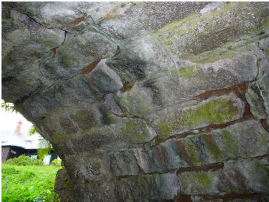
07_TRHLINA V MK NA VTOKOVÉ STRANĚ.JPG
