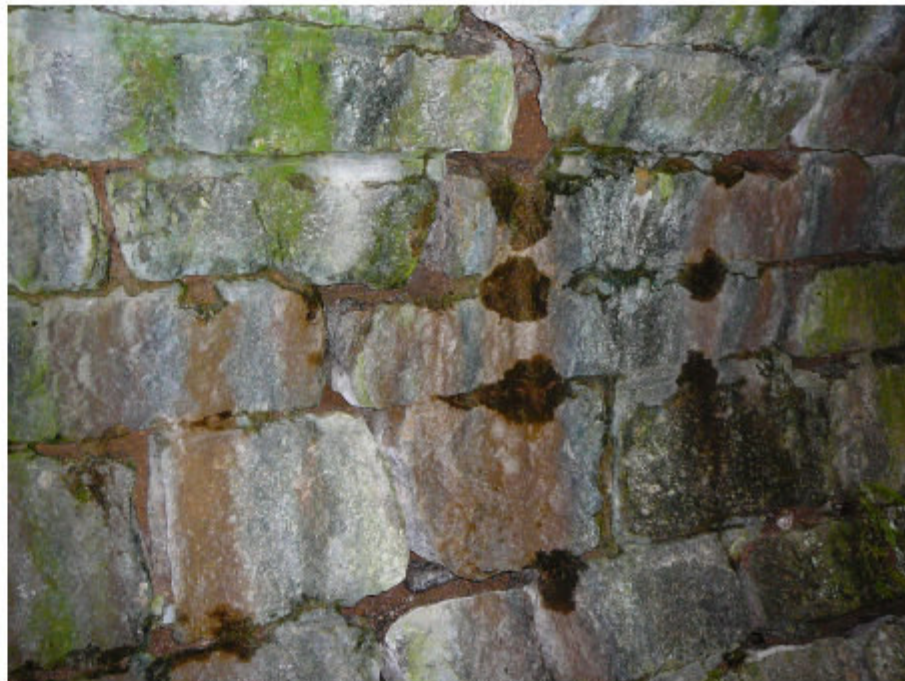
08_ZATĚKÁNÍ A TRHLINY V KLENBĚ.JPG
